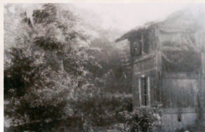
1949年3月，三临大队在桐山祇园寺成立旧址
