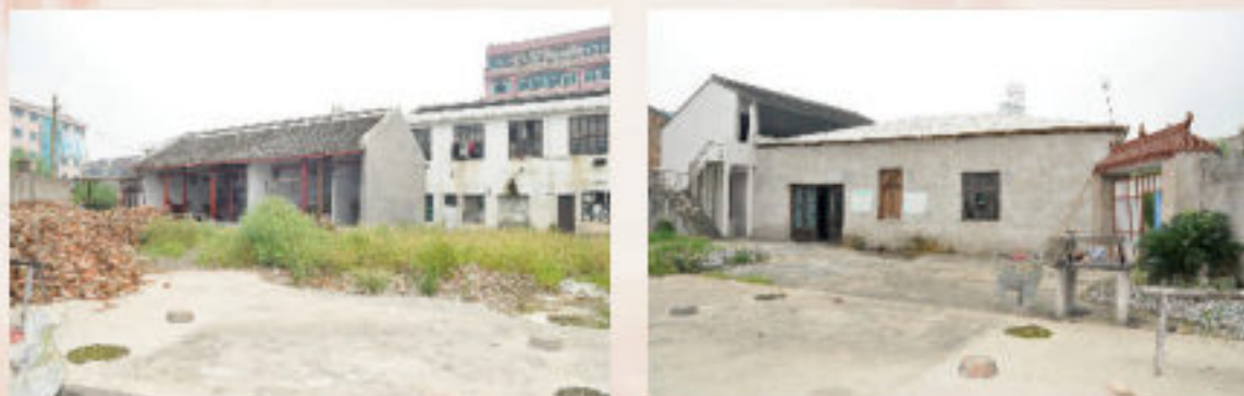
大溪东桥堂——中共温岭县委重要会议旧址
