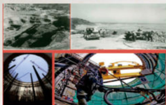
核电站施工场景
